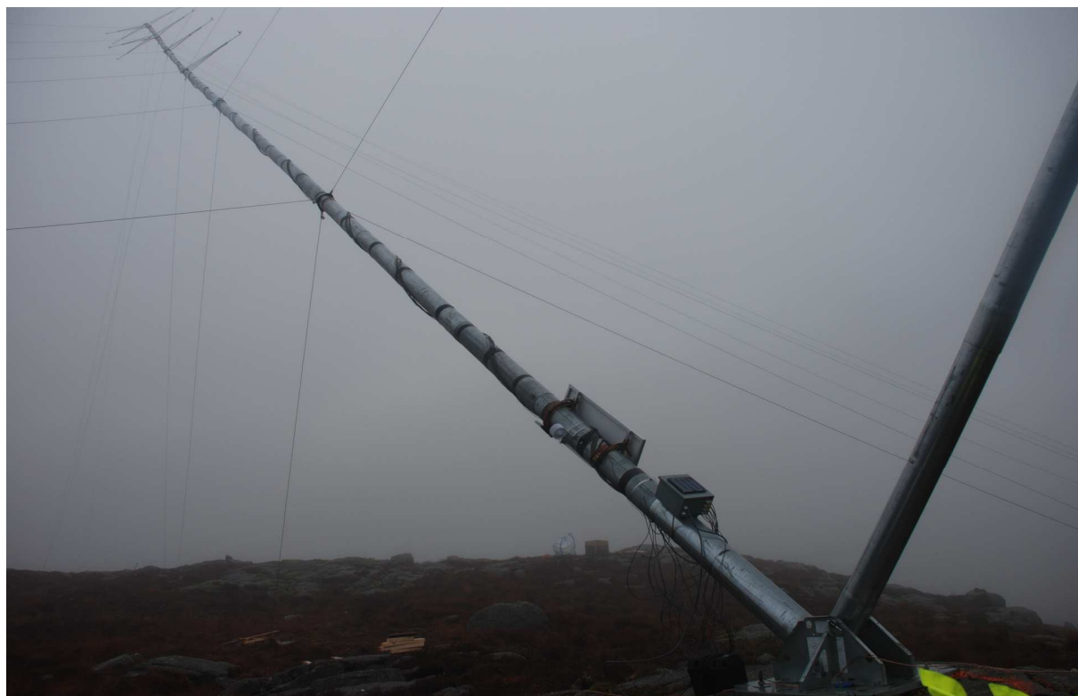
Figur 7. Installering av vindmålemast på platået mellom Ramnafjellet og Akslifjellet
